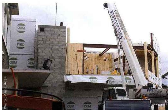
▲ Toutes les opérations de levage ont été effectuées par une grue de 40t placée sur la seule parcelle disponible, au pied du bâtiment.
