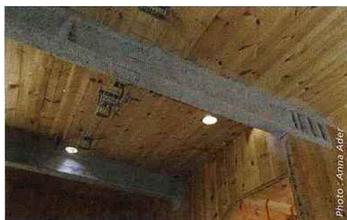
▲ Le plancher et les murs de refend du bâtiment ont été réalisés avec les panneaux en CLT de pin sylvestre, naturellement classe 2.
