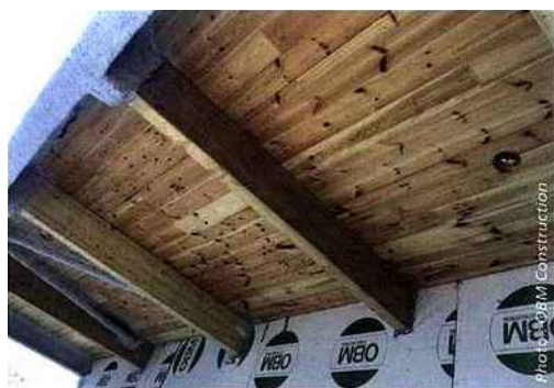
▲ Le grand porte-a-faux maintenu par la charpente métallique
