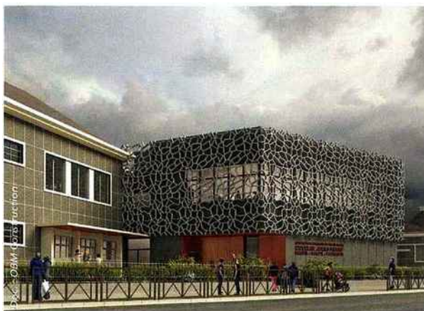
▲ Une résille métallique appliquée sur la façade apportera un aspect décoratif au bâtiment.
