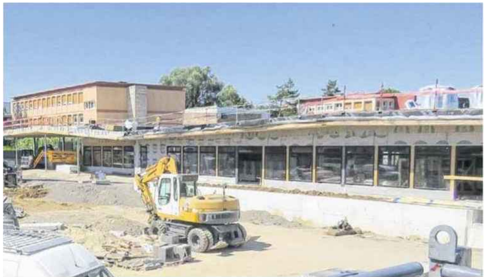
Les nouveaux bâtiments seront livrés en août 2018.
