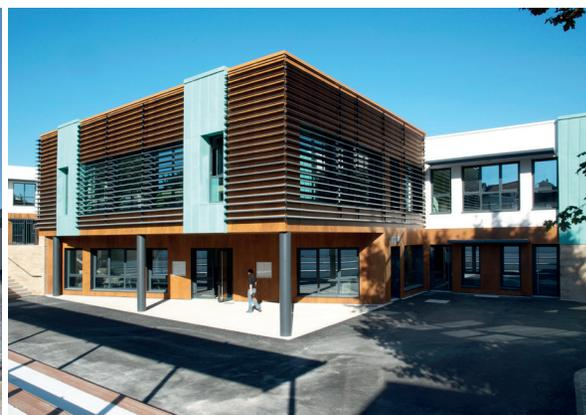
ces panneaux porteurs sont faits de cadres bois remplis d'isolant recouvert de 2 faces tôle. Cette technologie est très adaptée aux bâtiments géométriques. Elle est très économique et très rapide à réaliser, et donc intéressante pour des clients qui souhaitent construire une surface intermédiaire avec un côté esthétique agréable et l'utiliser très rapidement. La possibilité de parements intérieurs et extérieurs est sans limite.
