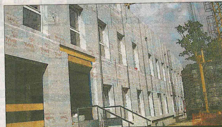
VISITE ARBOCENTRE. Arbocentre, dans la région, tente de structurer la filière bois, en resserrant les liens entre les acteurs du secteur. L'association organise ainsi, le vendredi 2 octobre, au matin, une visite d'OBM Construction et du chantier de la Dreal (photo). Inscription obligatoire auprès de f.grandchamp@arbocentre.asso.fr.
