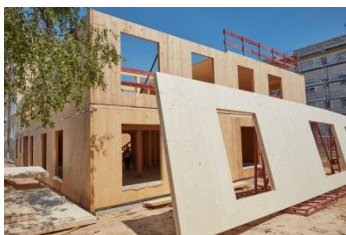
Murs en CLT, logements à Cormeilles en Parisis ;
